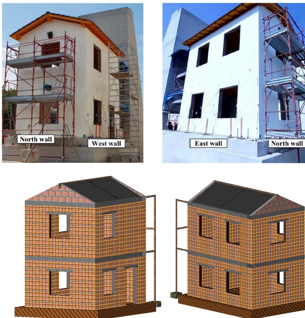
Figura 6: Immagini del prototipo di edificio e modello geometrico in 3DMacro®.
