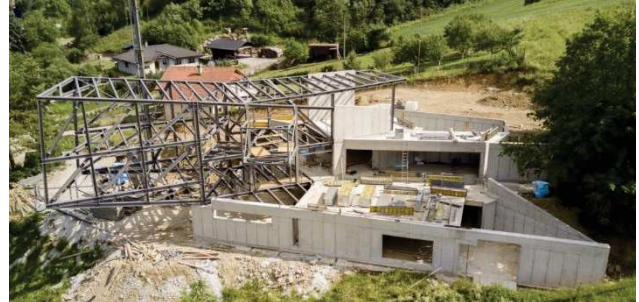
Cantiere in fase di costruzione
